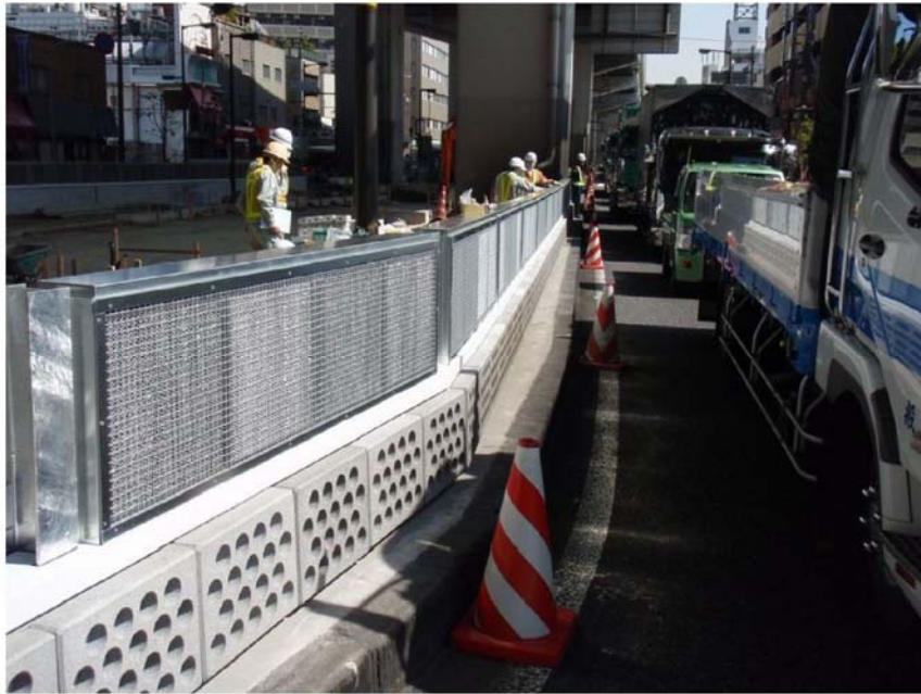
写真 2.5.5 ACF ユニットの設置工事
