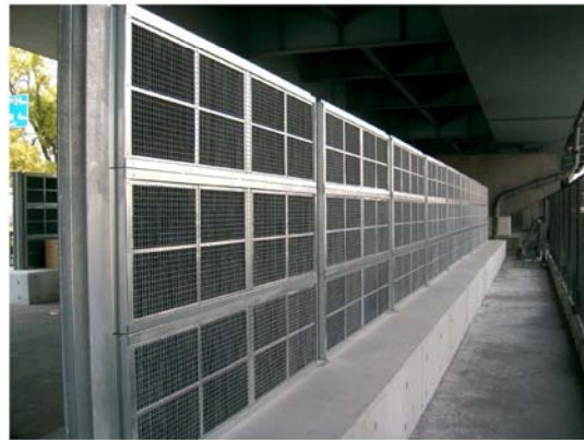
写真 2.3.2 国道 43 号に試験施工した ACF ユニット (大阪市西淀川区出来島)
