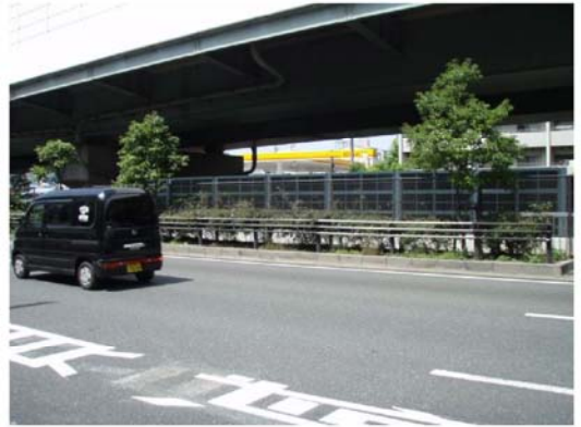
<国道 43 号下り車線側>
